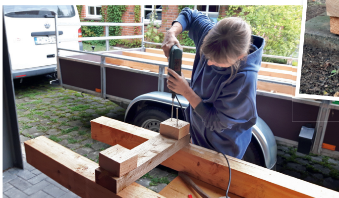
Die zugeschnittenen Holzteile werden zusammengeschaubt. Unter die Füße setze ich Gummiunterleger.
